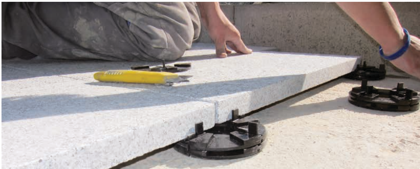
Plattenlager machen die Werksteinplattenverlegung für Landschaftsgärtner leicht und effektiv.
