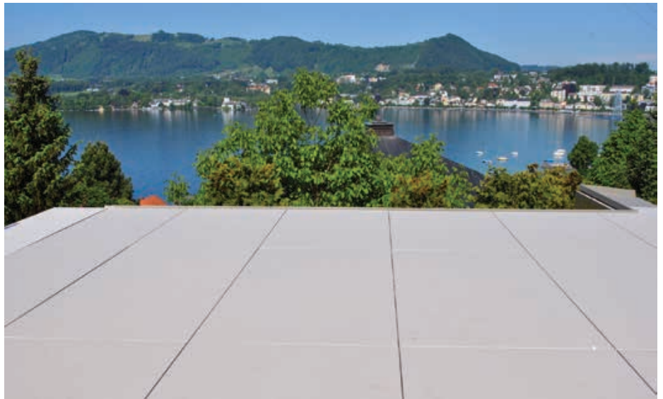
Ein echter Hingucker ist die mit Plattenlagern von Terra Level gestaltete Aussichtsterrasse. | Fotos: Terra Level, Linz
